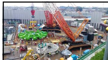
るところ。巨大なクレーン2台で70m下の立坑の中に下ろす予定。同時進行で、土砂搬出のためのベルトコンベア設
