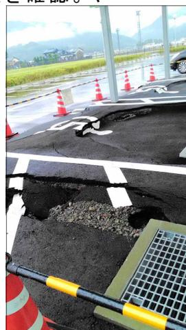
被害がなかったが、周辺が地盤沈下して段差ができた。収集車の計量器やランプウェイの段差を応急修理した。メインの東部工場が被災したため、フル稼働を続けている。
