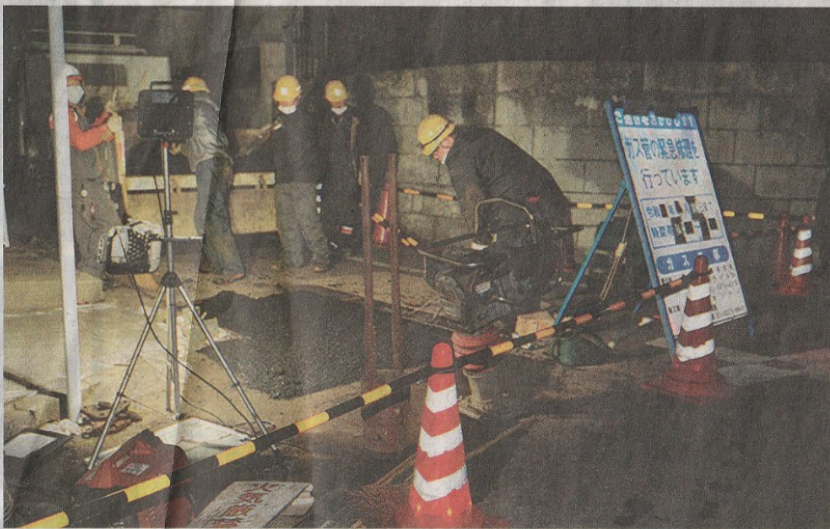
陥没・空洞が見つかった現場近くの市道で行われたガス管の復旧工事＝14日夜、調布市東つつじヶ丘で
